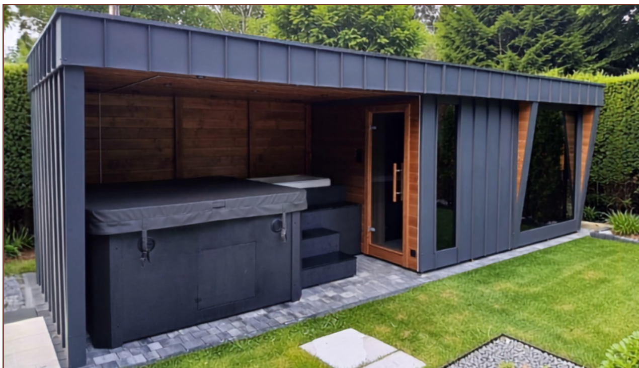
Kompleks SPA 8,5 x 2,2 m - realizacja 2025
